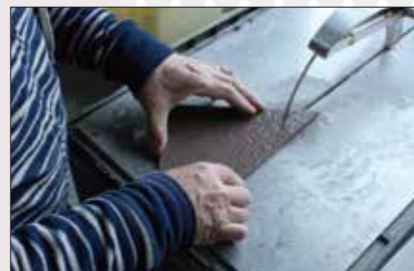
線に沿ってタイルを動かしながらリングソーでカットする。
