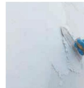
適量を金ゴテでとり、塗り厚が2mm程度になるように、壁面に押し付けながら圧着させていきます。
